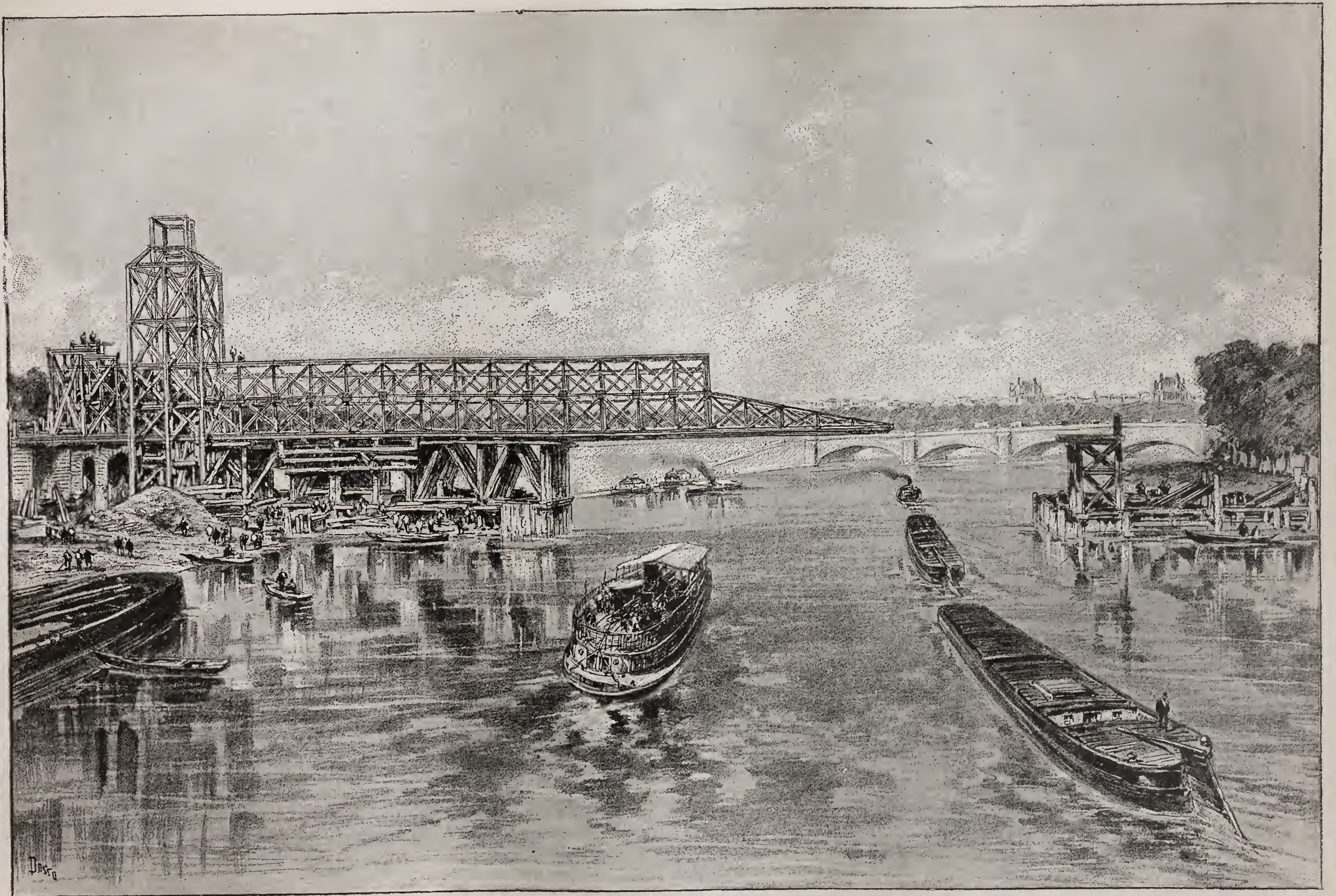
LA PASSERELLE DU PONT ALEXANDRE III. — Première opération du lancement : vue prise en aval.
